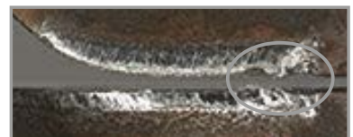
Filo de corte dañado
